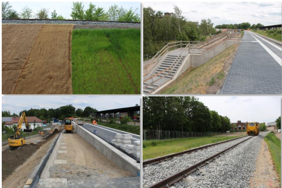
© NEB / Die Fotos zeigen den Baufortschritt am Regionalbahnhof Berlin-Wilhelmsruh von Anfang Juni 2026
